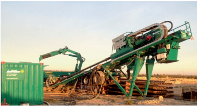
Fig. 5. 250 t Drilling Rig. Bild 5. 250 t-Bohranlage.
