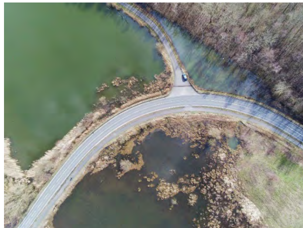
Figura 5: Imagen tomada con un dron Yuneec Mantis Q con cámara de 13 MP; La imagen muestra subsidencia minera en la zona de Werne-Stockum cerca del Datteln-Hamm-Kamal.
