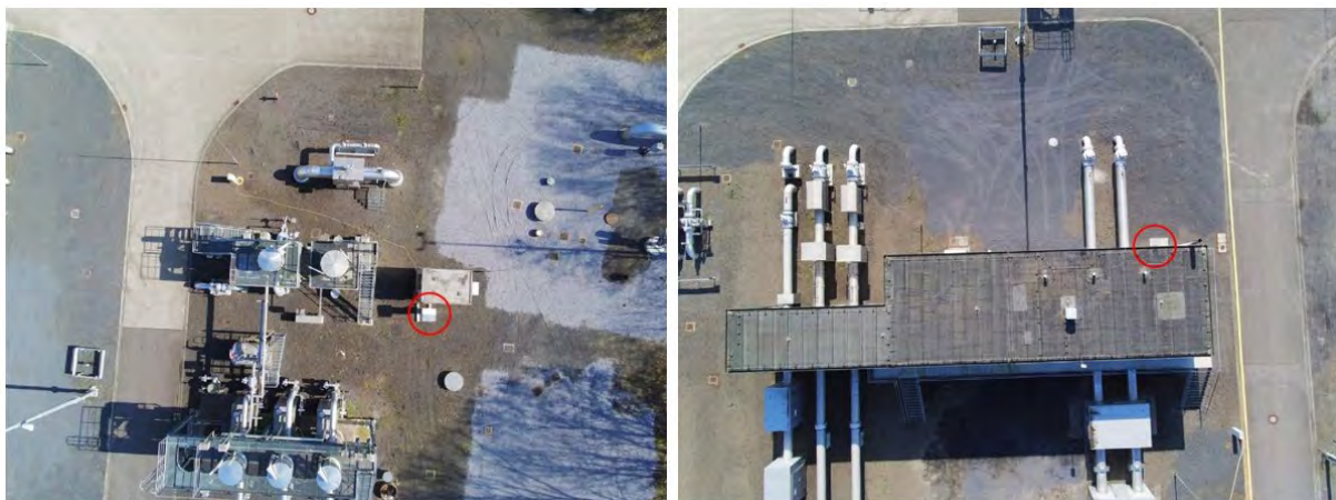
Figura 14: Superficies de prueba del depósito de almacenamiento de gas natural (sopladores = marcados en rojo).
