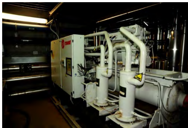
Figura 8: Sistema geotérmico en el edificio del centro de investigación (Foto: Bastian Reker).
