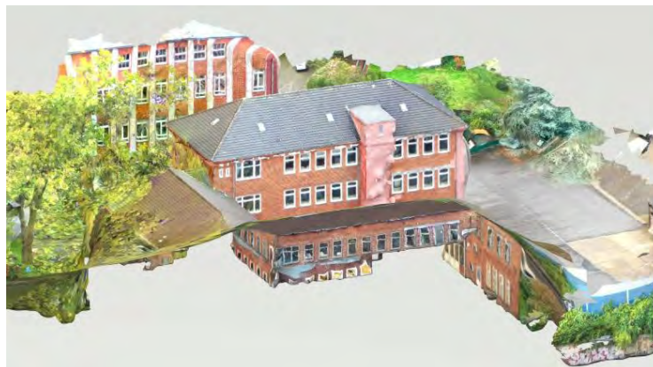
Figura 17: Se puede crear un modelo de edificio en 3D mediante una nube de puntos generada a partir de 33 fotografías aéreas inclinadas. Los datos se obtuvieron con un DJI Mavic 2 Pro con una cámara Hasselblad de 20 MP. Las partes de la fachada de estructura uniforme, como la torre de escalera, solo pueden reproducirse de forma deficiente debido a la falta de puntos de enlace. (Autor: Ing. Benjamin Haske. THGA Bochum, Forschungszentrum Nachbergbau).
