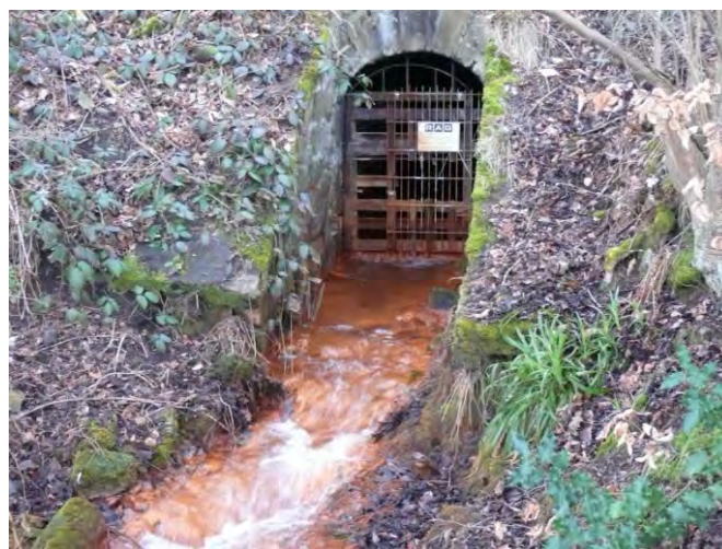
Figura 5: Salida del agua de la mina en una galería de drenaje (Foto: I. Michel).
