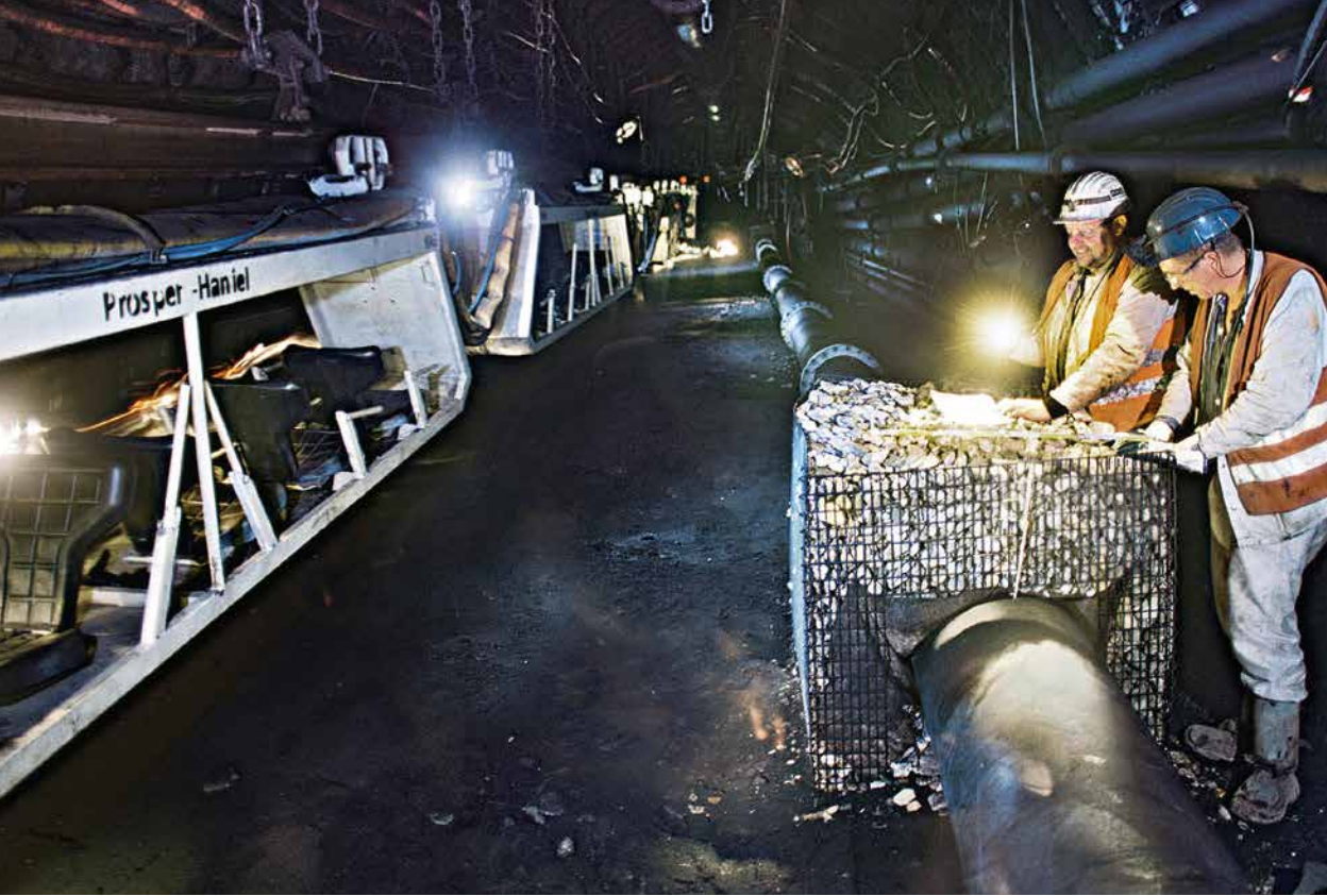
Abb. 9: Verlegung von Rohrleitungen mit eingeschalteten Kiesschüttungen zur Durchleitung des Grubenwassers (Foto: RAG Aktiengesellschaft).
