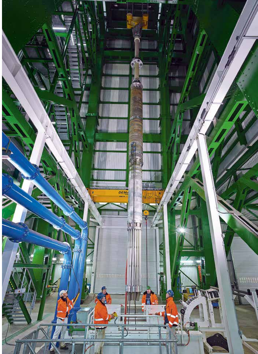
Abb. 2: Unterwassermotorpumpe am Wasserhaltungsstandort Walsum (Foto: RAG Aktiengesellschaft, Volker Wiciok).
