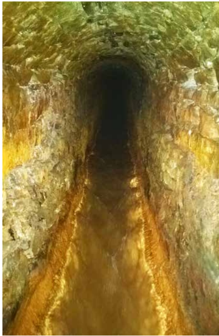
Abb. 34: Dickenberger Stollen (rechts: Rösche; links: Blick in den Stollen, Fotos: Bastian Reker).
